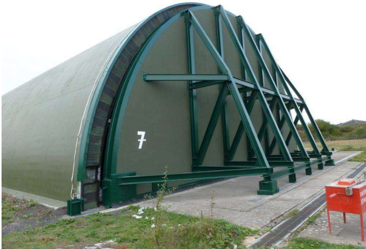
Figure 4 : vue extérieur de la hangarettte 0086 (HG 7) depuis le nord-est [photo ESID]
