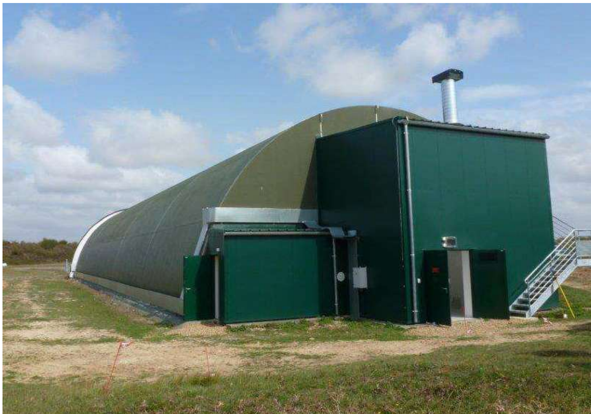
Figure 5 : vue extérieur de la hangarettte 0086 (HG 7) depuis le sud-ouest [photo ESID]
